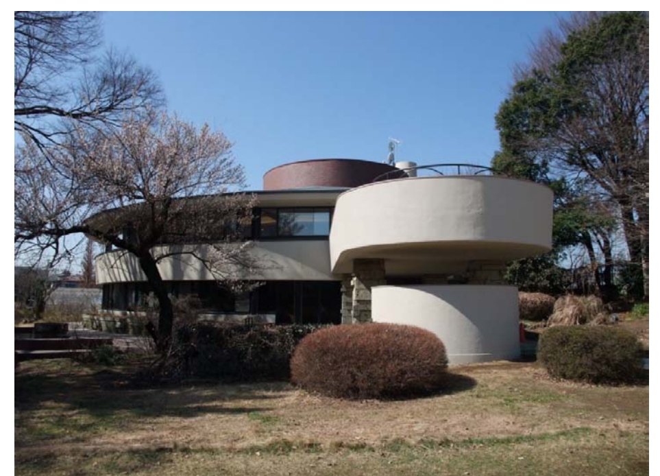
改修工事を終えた記念図書館(2010年)
