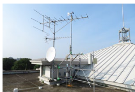
図-1 最高学部棟屋上露場
