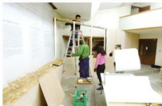
写真11 会場の製作。遮蔽された空間は、音楽室の備品や椅子などを格納するスペースでもある。
