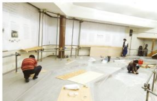
写真10 会場の製作。鉄製足場材を組み、そこに木製の展示台、プリントされた用紙を組み込む。
